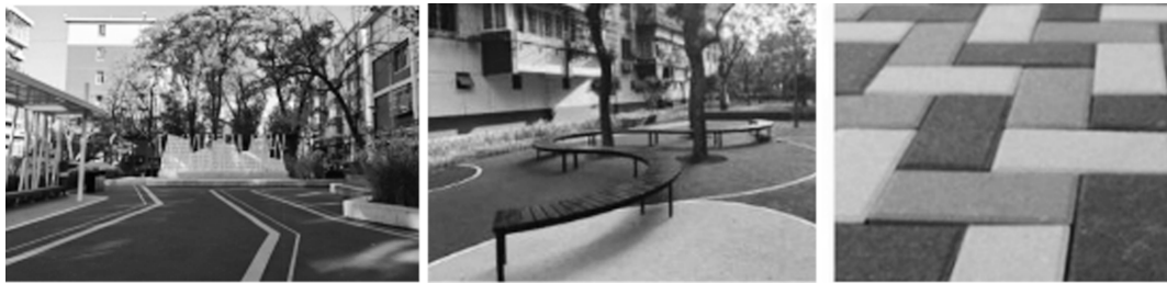
图6 彩色混凝土实景效果、彩色塑胶实景效果、彩色透水砖铺装实景效果
